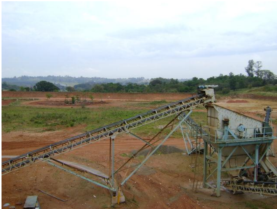
Vista da URM – Britador
