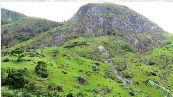
Figura 5.25 – Área de encostas e paredões rochosos, com suscetibilidades locais a quedas e deslocamentos de blocos – Rio Novo do Sul, ES.
