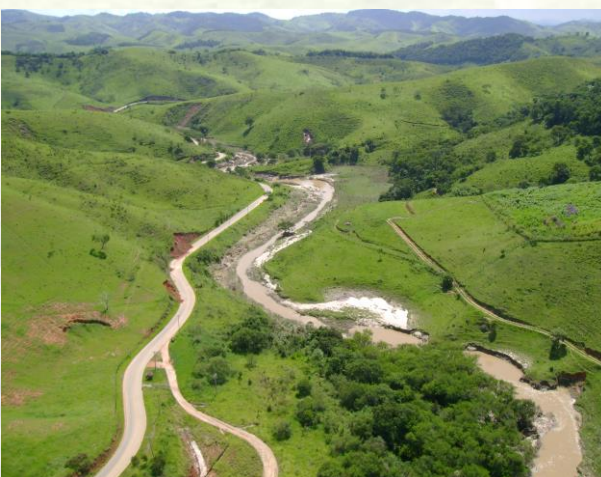
Figura 4.6 - Área afetada por enxurrada ao longo do canal do rio. Notar solapamento de taludes marginais – São Luiz do Paraitinga, SP. Foto: IPT/CTGeo.
