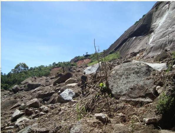
Figura 4.3 – Área afetada por queda de rocha em encosta – região serrana, RJ. Foto: IPT/CTGeo.
