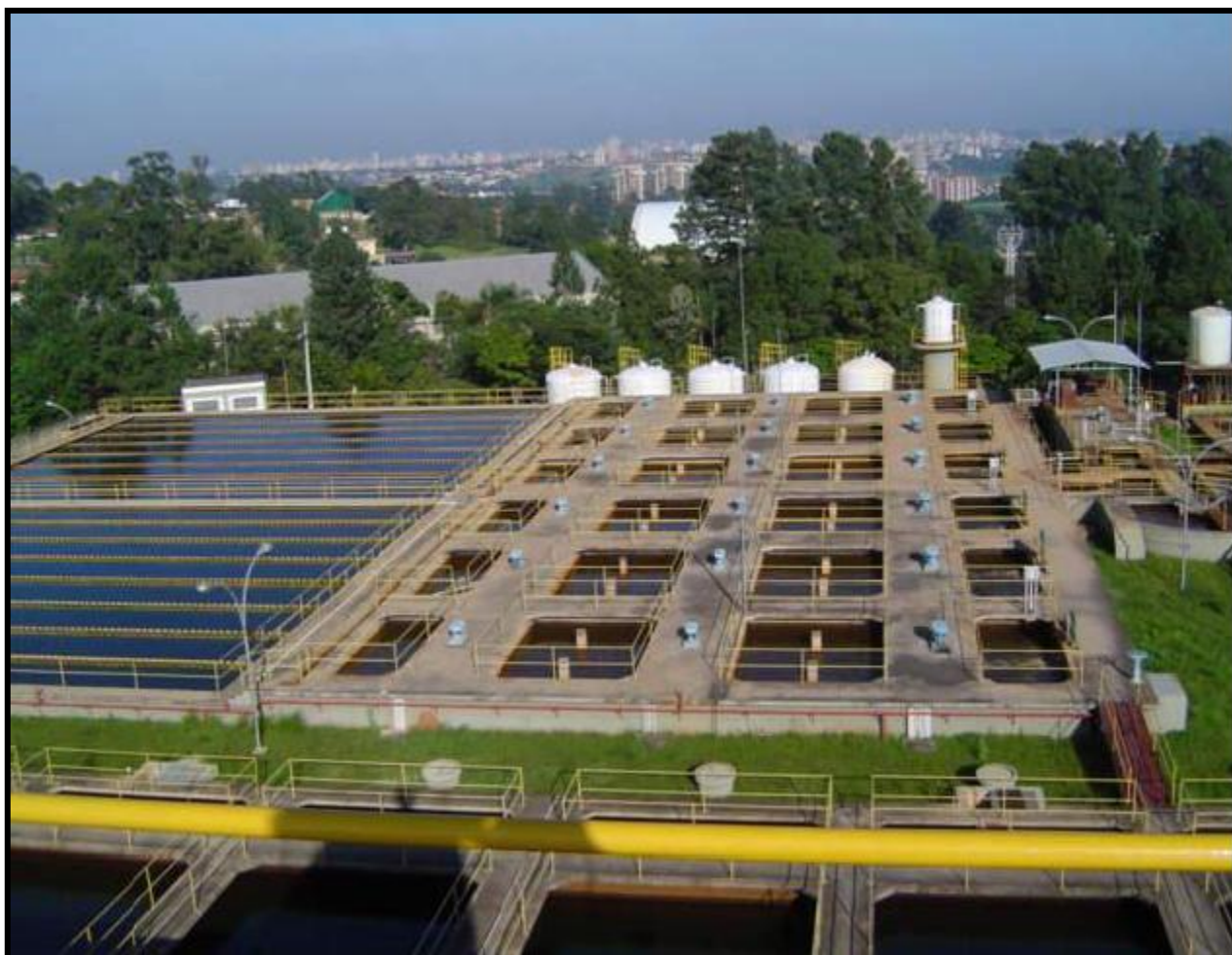
Figura 4.5: Vista superior dos Floculadores da ETA 04. Fonte: SANASA (2013).
