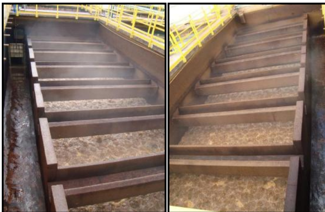
Figura 4.8: Filtro da ETA 03 em processo de limpeza. Fonte: SANASA (2013).
