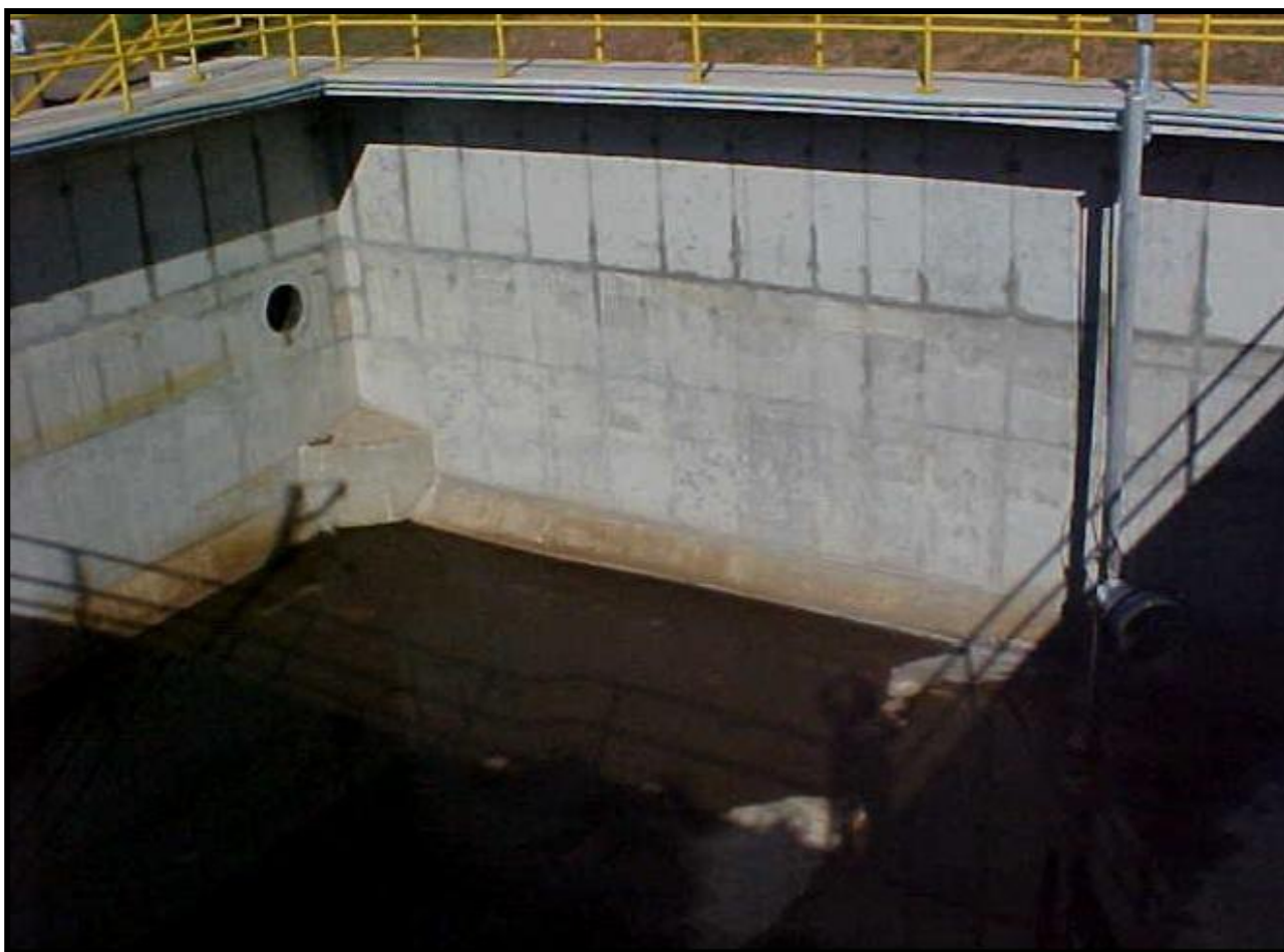
Figura 4.11: Vista interna do tanque de equalização. Fonte: SANASA (2013).
